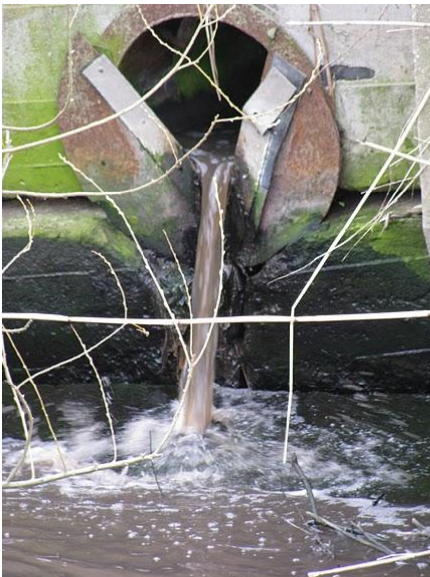
24. attēls. AS „Brīvais vilnis” saražoto un attīrīto notekūdeņu novadīšana izvadgrāvī pēc NAI (autors: Gunda Ozola, 2010 ).
