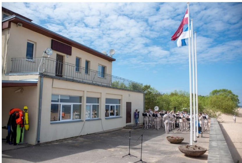
3. attēls. Peldvietas “Vecāķi” glābšanas stacijas ēka (avots: riga.lv)
